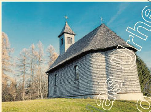
Komplett verschindelt: Dach und Fassade der Gahbergkapelle bestehen zur Gänze aus Holzschindeln.
